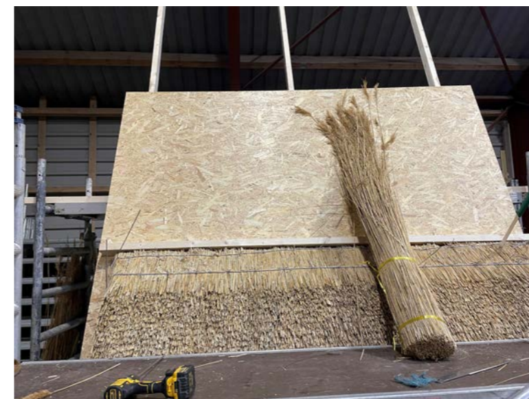
TÆKKET ELEMENT - PRØVE TIL PAVILLON UDFØRT AF TÆKKEMANDEN HORNEBY / THOMAS GERNER
