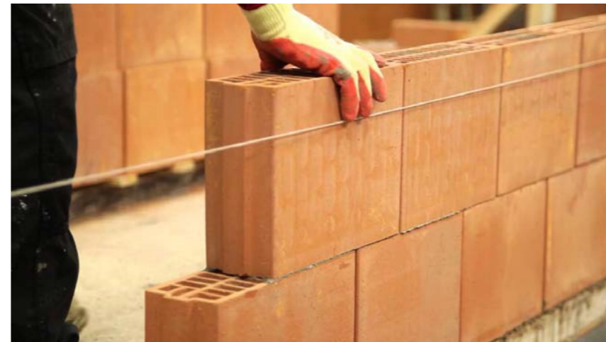
POROTON - TEGLBLOK - OPMURING INDERVÆG
